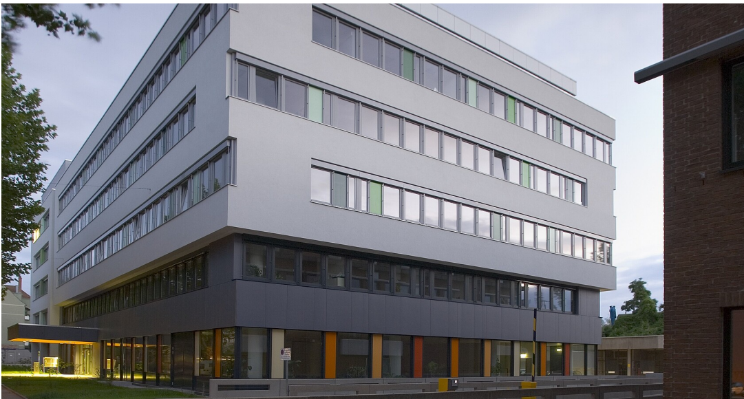
Außenansicht Gebäude Landesgesundheitsamt Baden-Württemberg in Stuttgart
