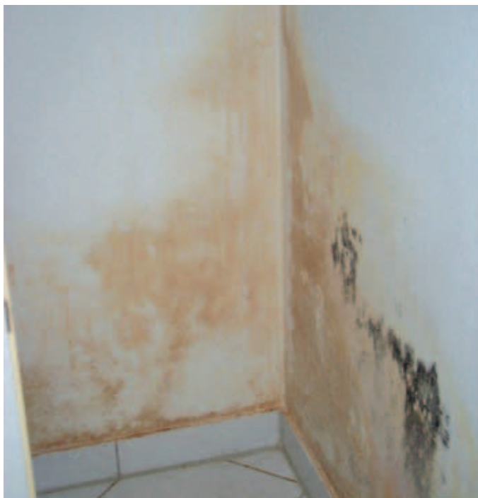
Изображение (Фото): Геометрический тепловой мост
