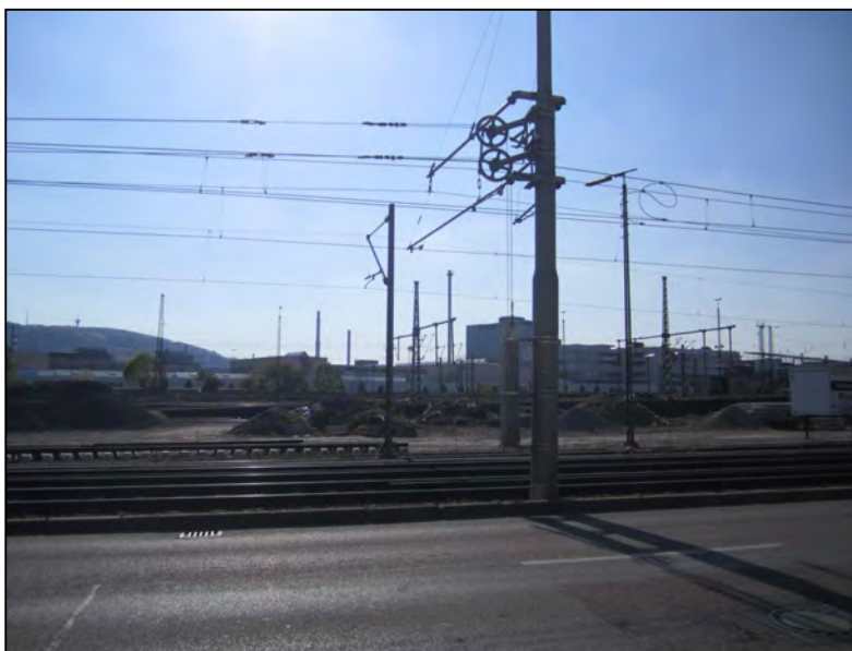
Abbildung 16: Bahngelände Untertürkheim mit Baustelle Stuttgart 21 (Foto: Geyer)
