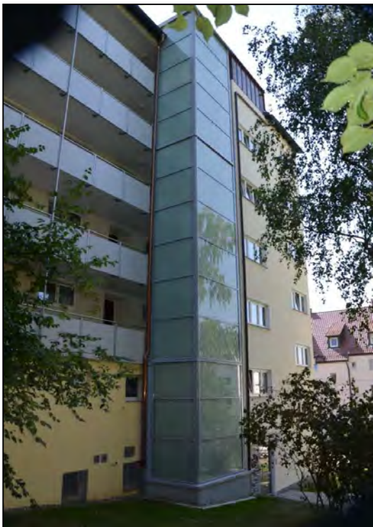
Abbildung 30: Nachträglich angebauter Aufzug (Foto: Knoke)
