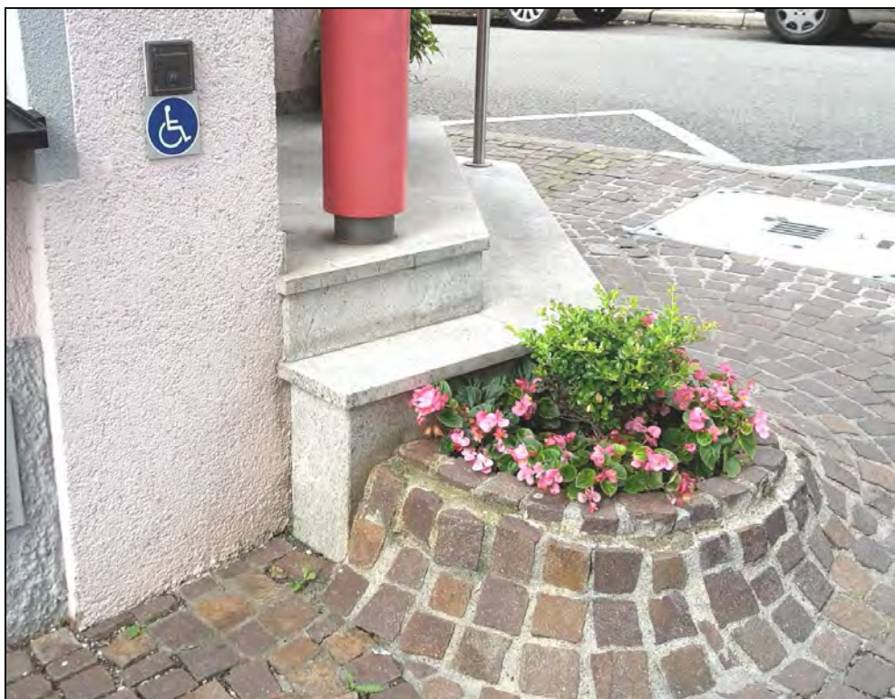
Abbildung 26: Rufknopf für Rollstuhlfahrer (Foto: Enslin)
