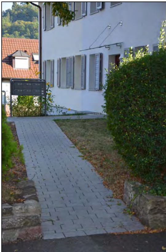
Abbildung 28: Barrierefreier Hauszugang (Foto: Knoke)
