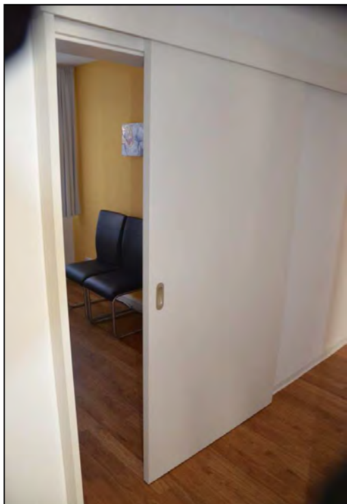
Abbildung 32: Schiebetür spart Platz (Foto: Knoke)
