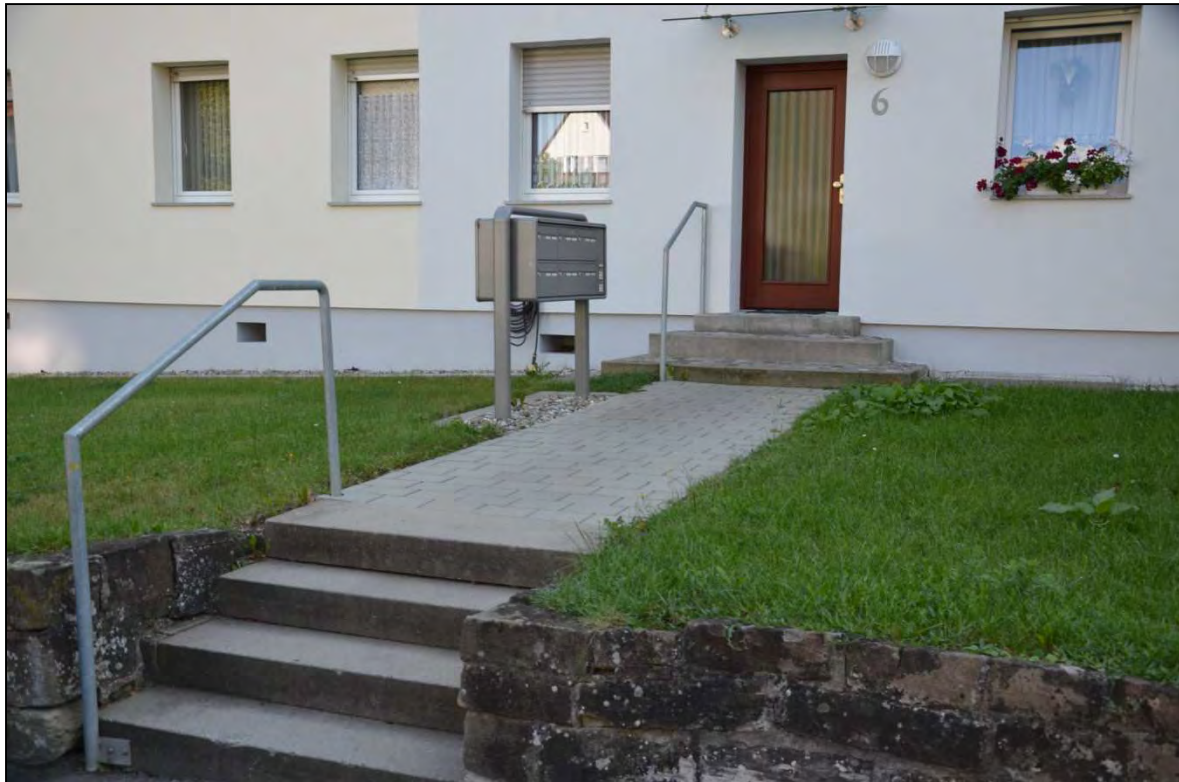
Abbildung 29: Handlauf (Foto: Knoke)
